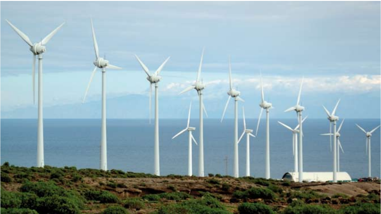
La energía eólica ha tenido un especial desarrollo empresarial en los últimos años y es la primera renovable en generación de electricidad.
