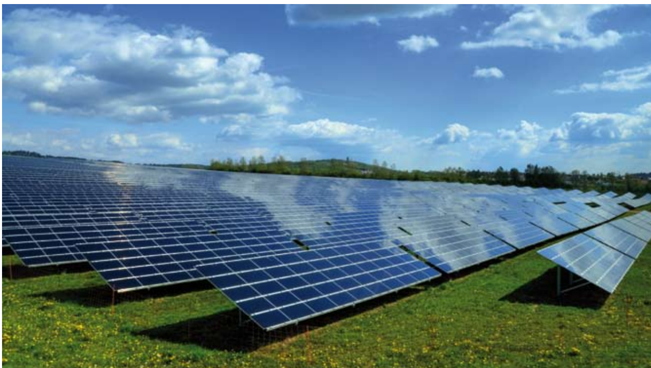
La energía fotovoltaica es una de las conocidas como renovables que en España ha contado con un mayor impulso.
